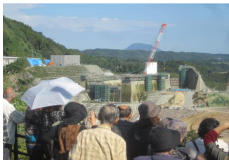
ダム工事の現場を見学する参加者
