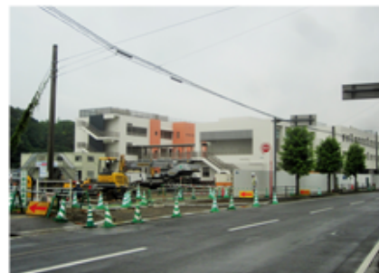
杵築中学校校舎が完成。2学期から使用開始。手前に体育館を建設中。卒業式に間に合うかな
