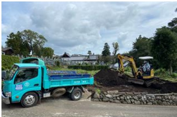
写真奥が墓地ならびに位牌堂・観音堂の屋根です。
