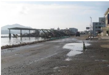
上は津波で被災した気仙沼魚市場付近。 H23.8.30撮
